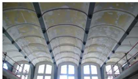
Voutains d'une des salles du Bureau central des télégraphes après transformation en 2008
