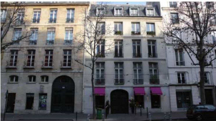
Ci-contre, des façades des 17e et 18e siècles à peine modifiées au 208 et 206, boulevard Saint-Germain
