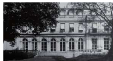
69, rue de Varenne, hôtel d'Orsay, clichés du début du XX e siècle. En haut : façade sur cour, en bas : façade sur jardin. Dhaap, Casier archéologique, 7e ardt., dossier 165
