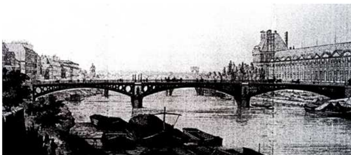
L'ancien pont du Carrousel, 1834, A.R.Polonceau
