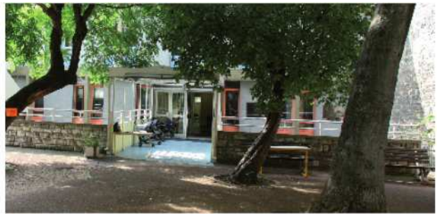
Entrée du centre Sainte-Agnès
