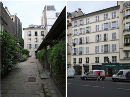
74, rue de Sèvres, façade sur rue et vue prise depuis l'immeuble sur rue vers le fond de la parcelle
