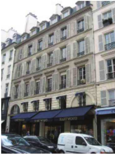
Entrée de l'impasse Valmy, 40, rue du Bac
