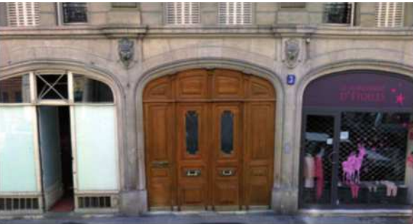
3, rue Chomel, Vramant architecte, 1879
