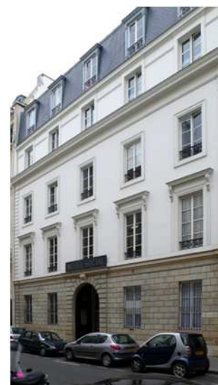
Le musée social, rue Las Cases, bâtiments des années 1830, nivelé et modifié par E. Vaudremer en 1895
