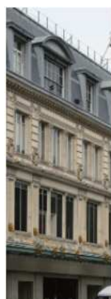
Détail de la façade sur la rue Velveau
