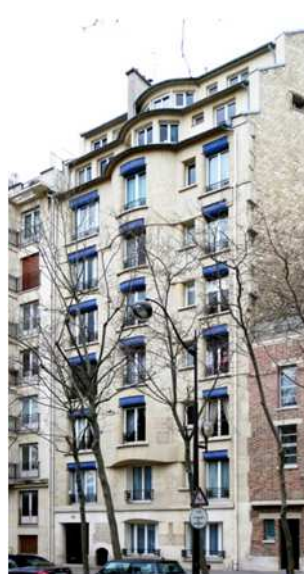
172 avenue Duquesne, Architecte Henri Sauvage
