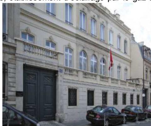
25, rue Barbet-de-Jouy, Hôtel de la Tour du Pin, construit par Louis Visconti en 1844. Il abrite actuellement l'Ambassade de Tunisie.
