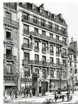
Immeuble de rapport, habitation et agence de l'architecte Julien Guadet, 240 bis bd St Germain
