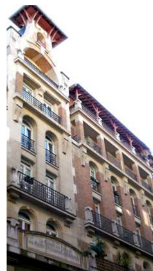
Maison des Dames des PTT, rue de Lille
