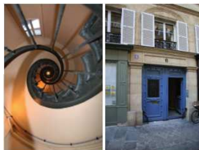
6, rue du Pré aux Clercs, escalier en vis construit dans une tourelle hors-oeuvre sur la cour
