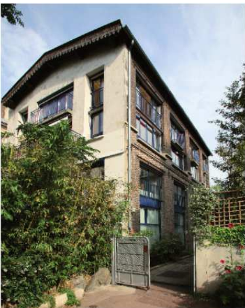
Bâtiment en pans de fer et brique
