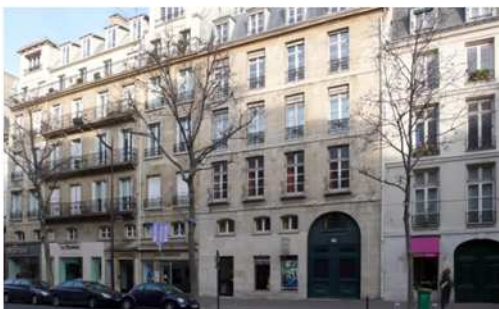
Les n° 212, 210, 208 Bd Saint-Germain Les façades du XVIII e siècle sont simplement ici modernisées
