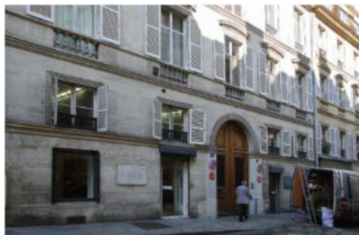
6-8, rue du Pré aux Clercs, deux immeubles construits par Garrez, entrepreneur, décrits dans la Revue Générale de l'Architecture par César Daly.
