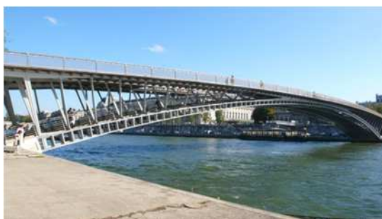
La passerelle devant la rue de Solférino, Marc Mimram, architecte
