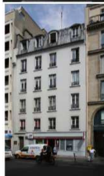
78-80, rue de Sèvres. Façades sur rue / vue sur le bâtiment en pierre de taille construit par les Frères des Ecoles chrétiennes, implanté en fond de cour.
