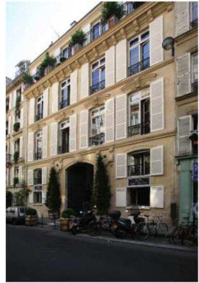
5, rue du Pré aux Clercs, immeuble d'habitation bourgeois implanté sur une parcelle peu profonde, qui empêche la construction de bâtiments annexes dans la cour. Néanmoins, cet immeuble est imposant dans ses proportions, avec un porche d'entrée englobant le rez-de-chaussée et l'entresol. Le décor de façade reste assez simple en reprenant les bandeaux moulurés et filants sur chaque étage. Le bel étage est orné de larmiers cintrés et la corniche moulurée à modillons soutient le balcon filant du dernier niveau..
