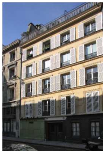
14, rue du Pré aux Clercs, Immeuble ordinaire de bonne facture.
