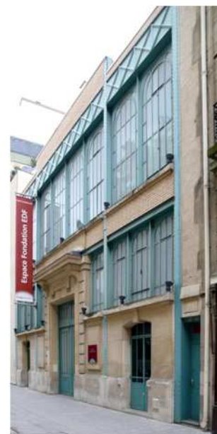
n°7 rue Récamier Sous-station électrique
