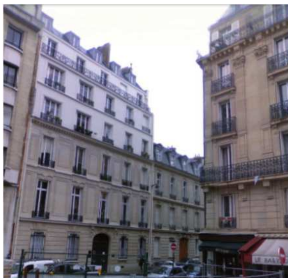
12 et 10, rue Chomel, maison construites entre 1872 et 1874. Celle du n°12 a été surélevé au maximum des autorisations.
