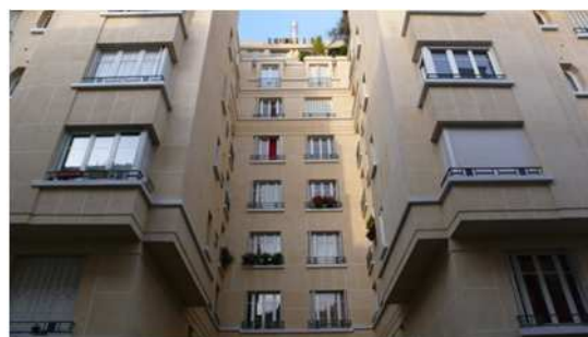
Immeuble 14-16 rue Pierre Leroux
