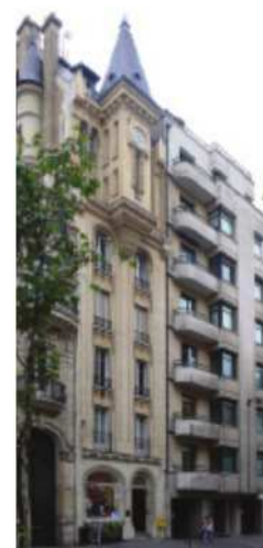
Immeuble Marc Sangnier, 32 boulevard Raspail mitoyen du 30 construit par l'architecte Pol Abraham
