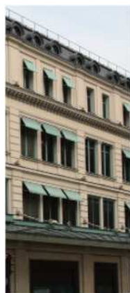
Détail de la façade sur la rue de Sèvres
