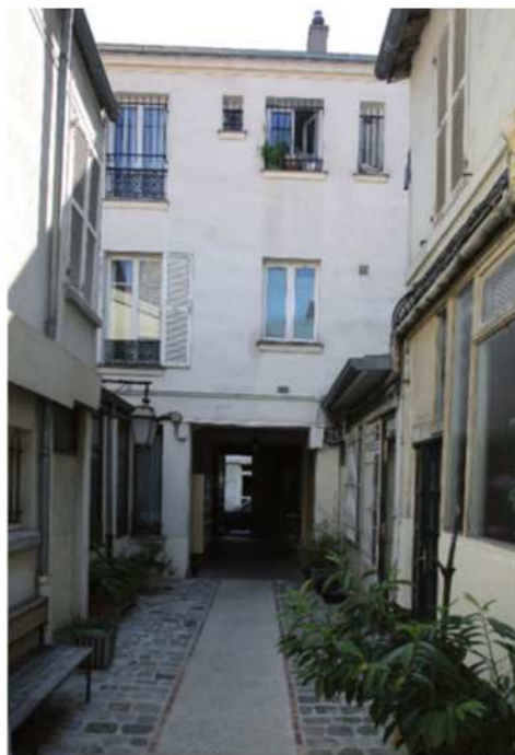
Maison à loyer sur rue, façade arrière donnant sur la cour.
