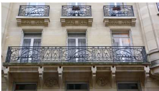
Angle rue Monsieur, rue Oudinot, détail
