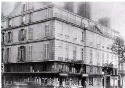
Deux hôtels particuliers réunis sous une même enveloppe par Robert de Cotte, à l'angle du quai d'Orsay et de la rue du Bac (modernisés au XIX e siècle, détruits lors de l'extention de la Caisse des Dépôts
