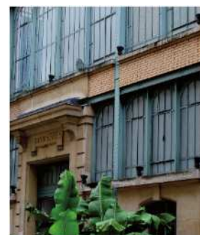
6, rue Récamier, Sous-station Sèvres, Paul Friesé, 1910. Depuis 1990, le bâtiment est devenu l'espace Electra, lieu d'exposition de la Fondation EDF.
