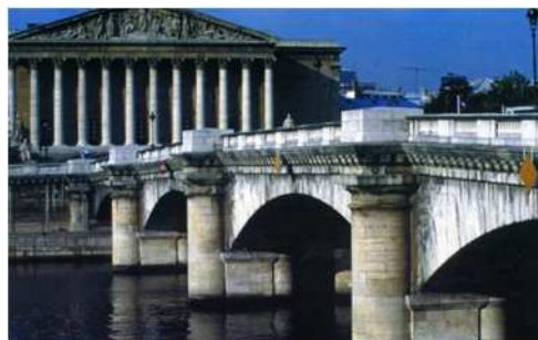
Le pont de la Concorde par Rodolphe Perronet, élargi en 1929-31 – Vue actuelle
