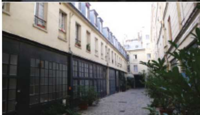
34, rue Saint Dominique, en haut le côté des remises, en bas l'immeuble des écuries et le logement des cochers et des palefreniers
