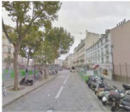
DP 8 - Photo de l'existant, vue lointaine
