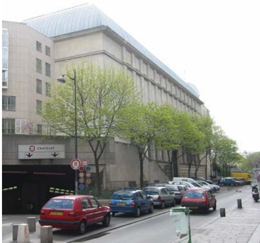
La façade et son pignon sur l'entrée du souterrain.
