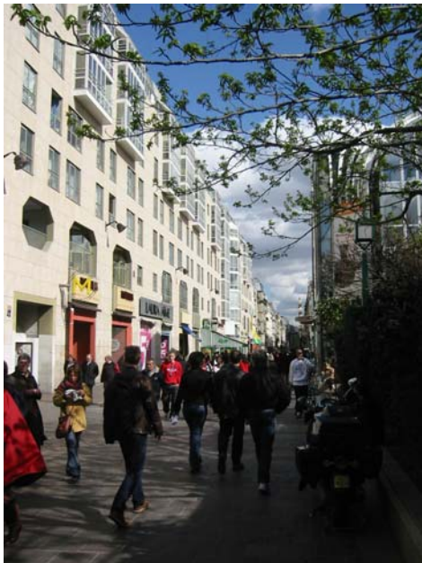
façade rue Rambuteau
