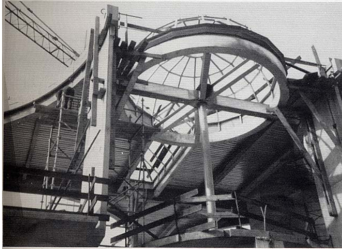
Vue de chantier
