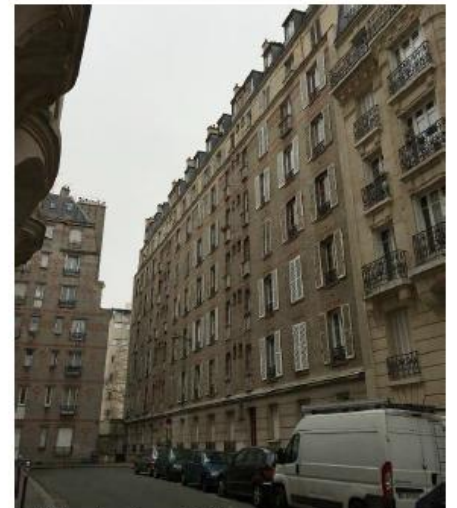
Les antennes ne sont pas visibles depuis ce point de vue
