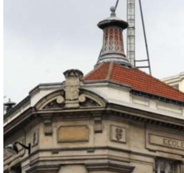
Ci-dessus : élévation du pan coupé et détail des petites lanternes de ventilation établies sur les combles des classes (Nouvelles Annales de la Construction, 1895), élément aujourd'hui parfaitement conservé.
