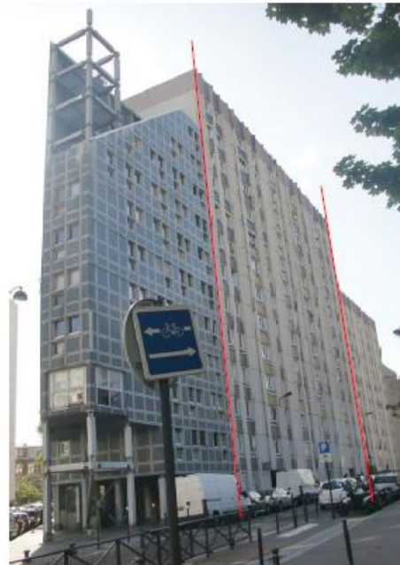
DP 8 - Photo de l'existant, vue lointaine
