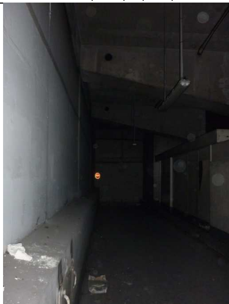
Photo 5 : Vue de la hauteur sous plafond au niveau de la sortie du site - Source DVD
