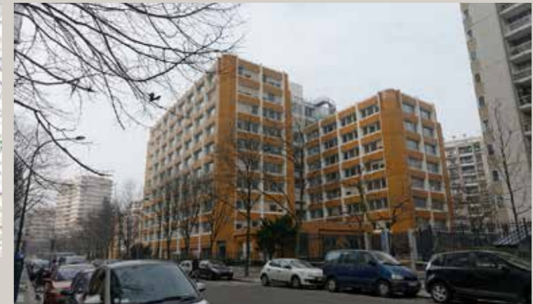
Vue actuelle de l'immeuble sur la rue Archereau.
