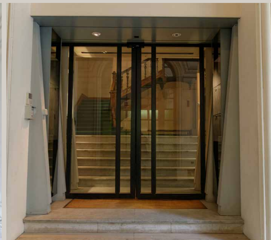
Vues du passage cocher et des emmarchements permettant d'accéder au hall. Le projet prévoit de ramener tout le RDC au niveau de la rue ce qui implique la démolition de l'escalier en bois existant et l'abaissement des allèges en façade
