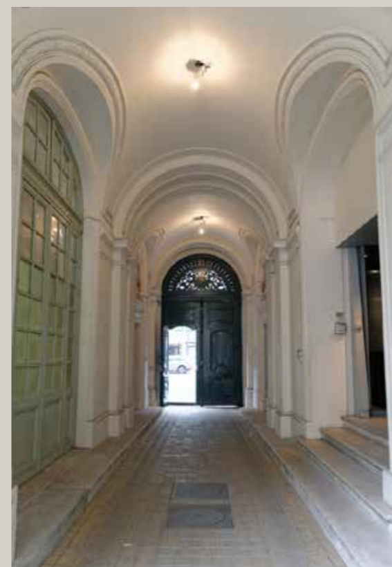
Vues du passage cocher et des emmarchements permettant d'accéder au hall. Le projet prévoit de ramener tout le RDC au niveau de la rue ce qui implique la démolition de l'escalier en bois existant et l'abaissement des allèges en façade
