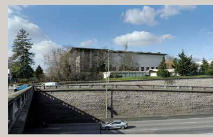
Vue de la façade est du musée depuis le périphérique en limite de Saint-Mandé.
