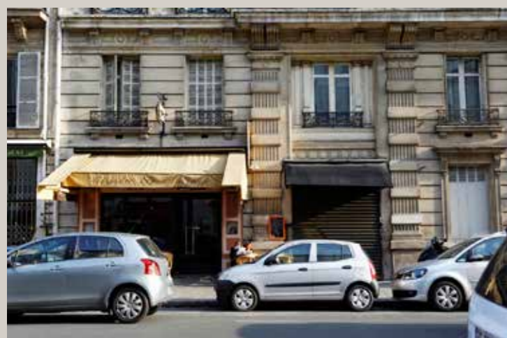
Détail du rez-de-chaussée, avec, entre les pilastres, un ancien porche.
