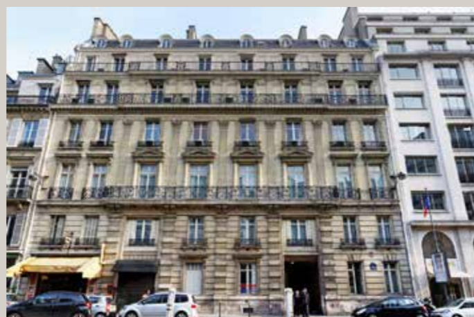
Vue actuelle de la façade sur la rue du Faubourg Saint-Honoré. À l'origine, deux porches s'ouvriraient de part et d'autre du corps central.
