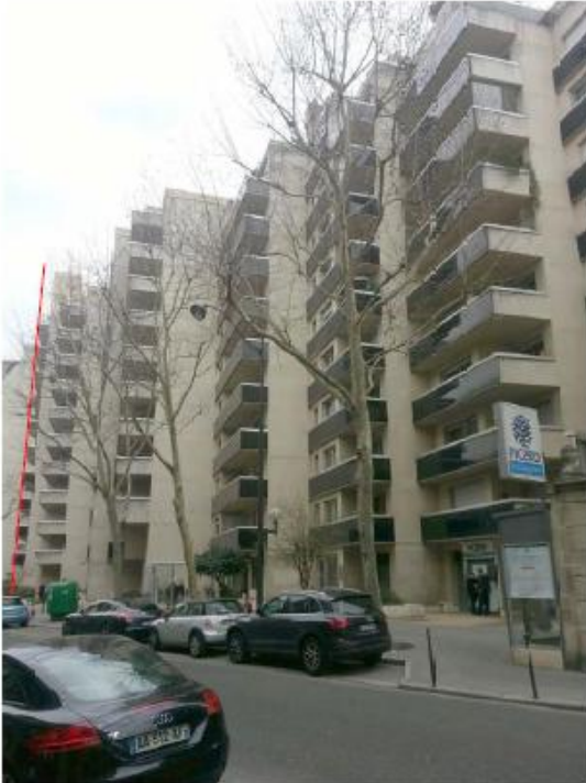
DP 7.1 - Photo de l'existant
