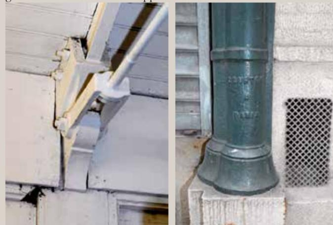
À gauche, détail d'une ferme avec l'ancrage d'un tirant et, à droite, détail montrant la base et le socle d'une colonne de fonte.
