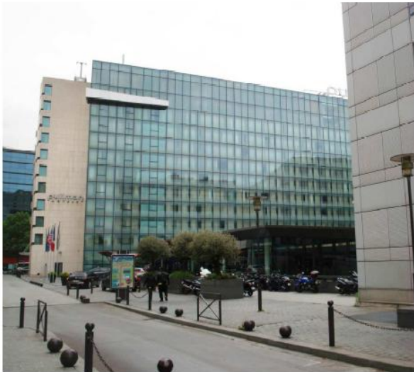
DP 7.1 - Photo de l'existant
