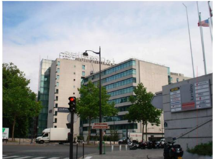
DP 8 - Photo de l'existant, vue lointaine
