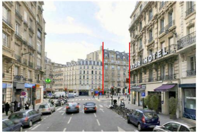
DP 8.1 - Photo de l'existant, vue lointaine
