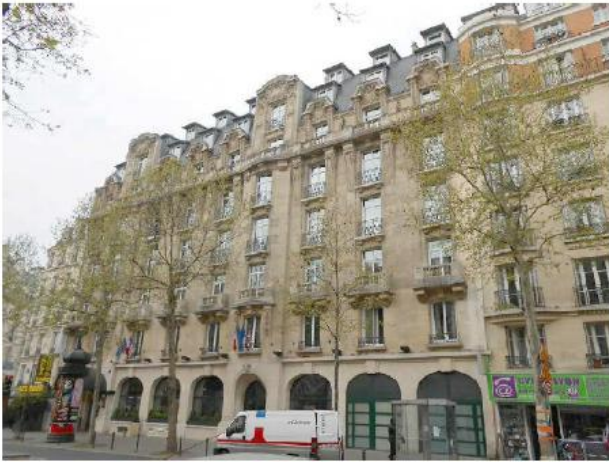
DP 7.1 - Photo de l'existant
