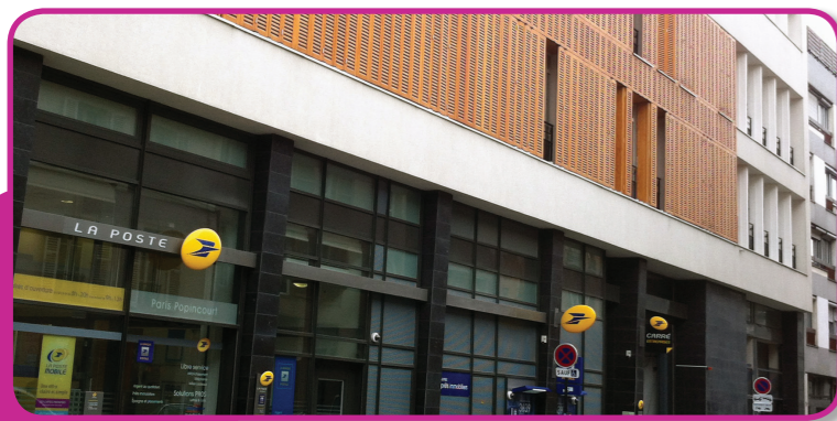
une réhabilitation complète de l'immeuble
