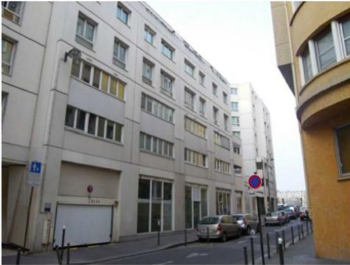
DP 7.1 - Photo de l'existant
