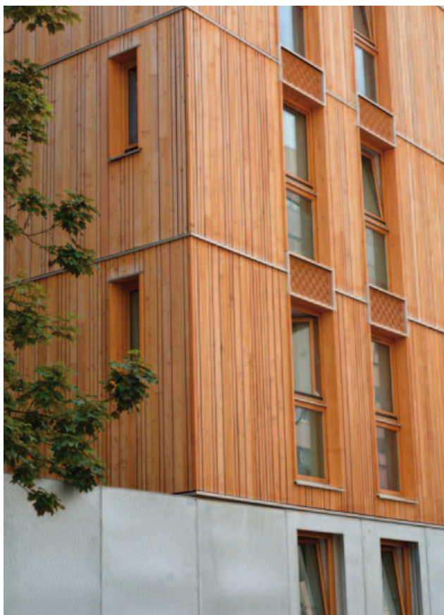
Rénovation logements sociaux HSF Soleil. © S. Bouchereau
