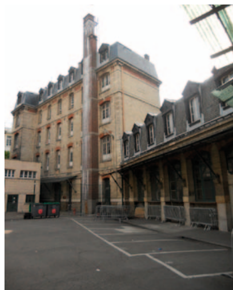
33 rue de l'Aqueduc (10 e ). © Mairie de Paris
