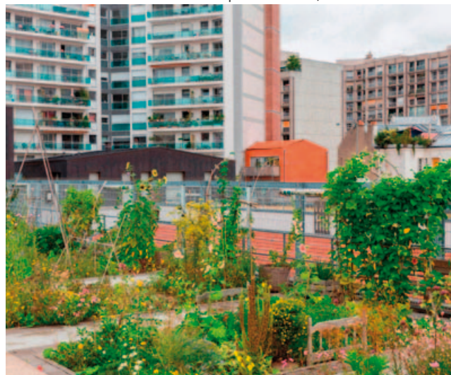
La végétalisation des toitures permet de retenir l'eau de pluie. Gymnase Vignoles (20 e ). © M. Verhille
