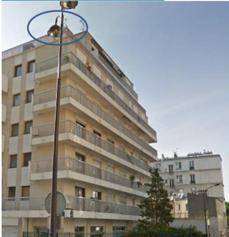
Etat projeté : pas de modification visible
