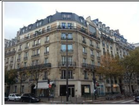
PHOTO DEPUIS LA RUE AVANT TRAVAUX
