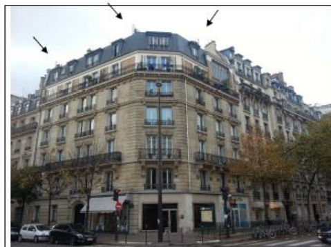
PHOTO DEPUIS LA RUE APRES TRAVAUX (SANS IMPACT VISUEL)
