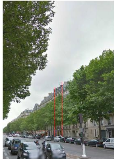
DP 8 - Photo de l'existant, vue lointaine
