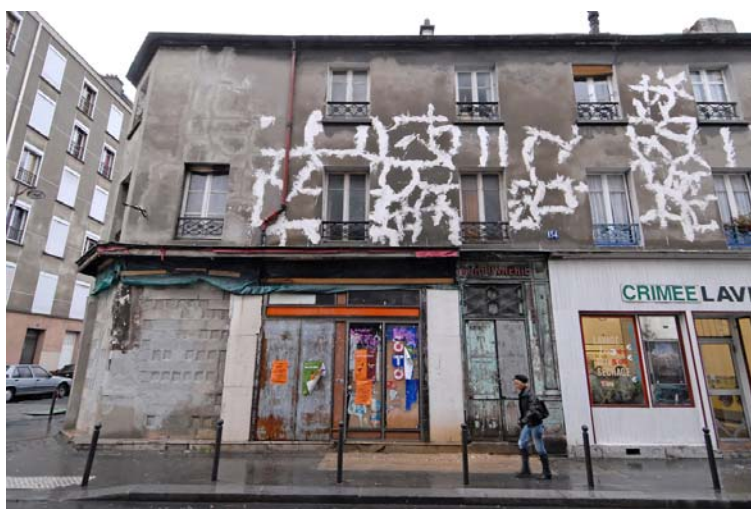
Photos de l'existant : ci-dessus, vues de l'immeuble d'angle 2, rue de Colmar et 154, rue de Crimée.
