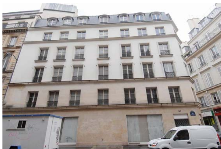
Ci-dessus : façade de l'immeuble d'angle, façade du n°50 rue Laffitte.
