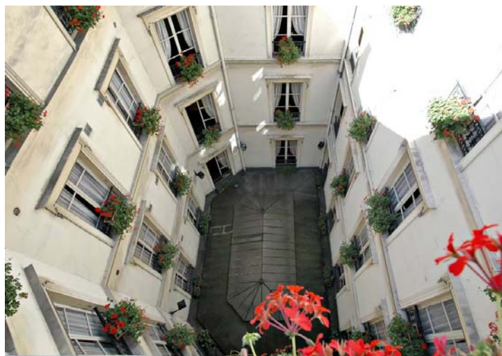
Ci-dessus : photo de la façade rue Duphot, et vue de la cour de l'hôtel.
