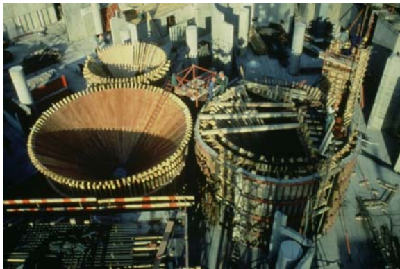
photo du chantier (Paul Chemetov)
