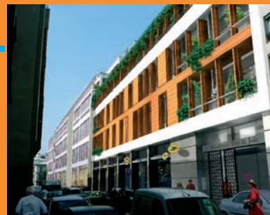
Opération Toit et Joie, une démarche environnementale certifiée
