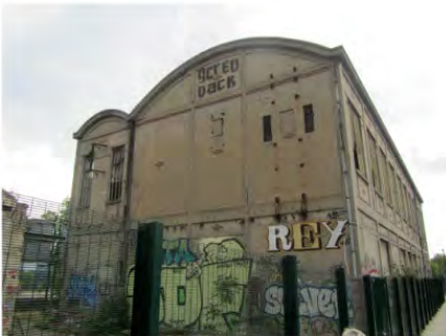
L'usine électrique de la Rapée
