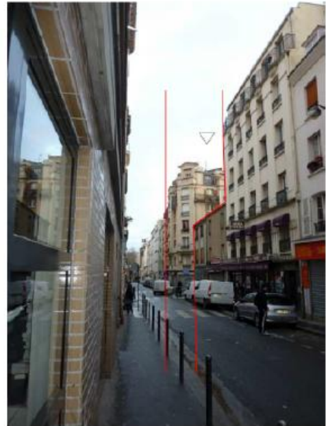
DP 8 - Photo de l'existant, vue lointaine
