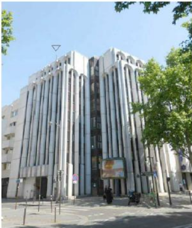
DP 7.1 - Photo de l'existant
