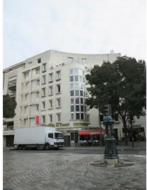
DP 8 - Photo de l'existant, vue lointaine
