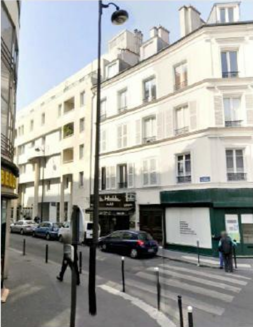
DP 7.1 - Photo de l'existant
