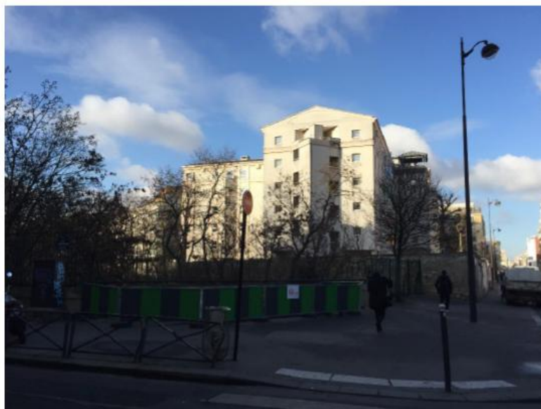
Les antennes ne sont pas visibles depuis ce point de vue
