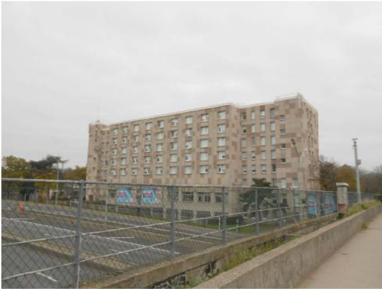
DP 7.1 - Photo de l'existant
