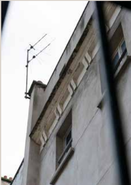
Détail de la façade nord actuelle du bâtiment sur cour.
