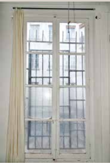
Détail d’une fenêtre du bâtiment cour.
