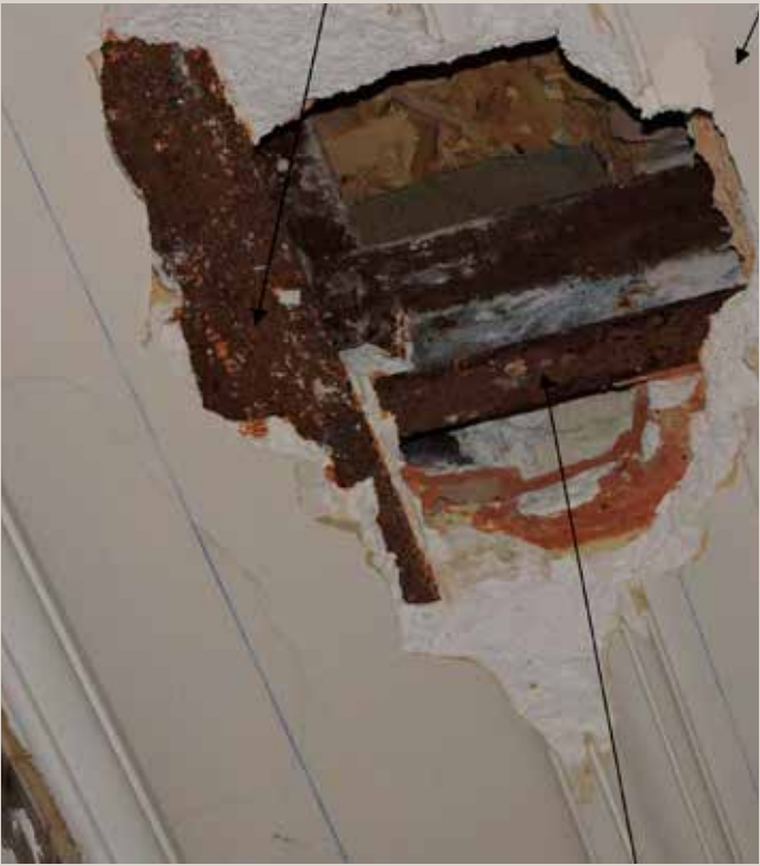
Vues actuelles des sondages réalisés montrant une structure métallique au droit des refends (sondages réalisés au R+1 © Studios architecture).
