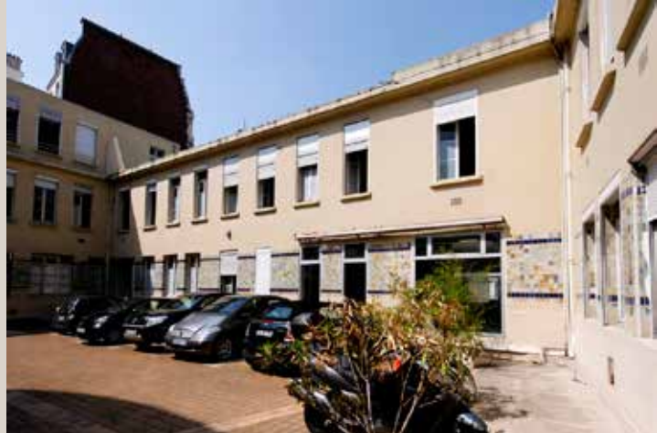
Vue actuelle du revers de l'immeuble sur rue. À droite, la baie d'un ancien porche condamné.
