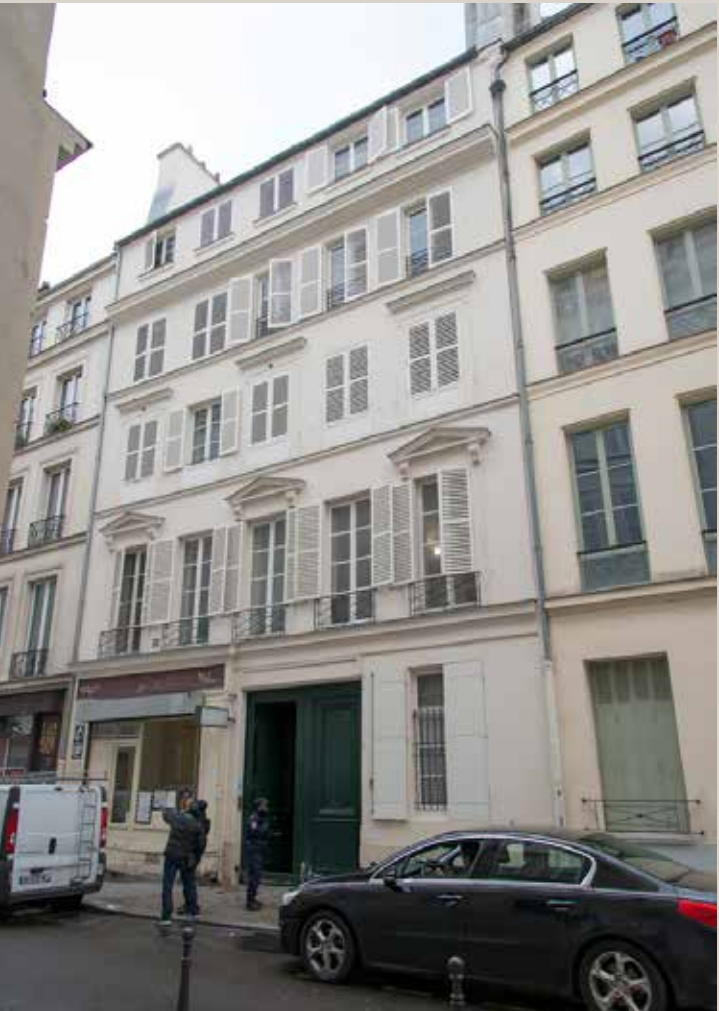
Vue actuelle de la façade sur rue, qui a été enrichie d'un nouveau décor en 1840.
