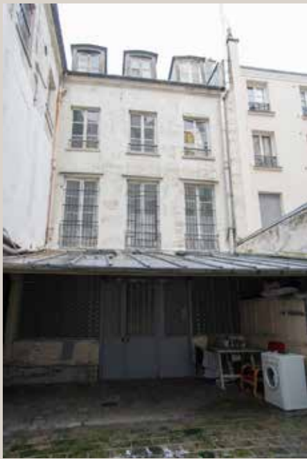
Façade actuelle du bâtiment sur cour.
