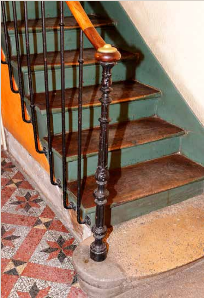
Vue actuelle du départ de l’escalier principal.
