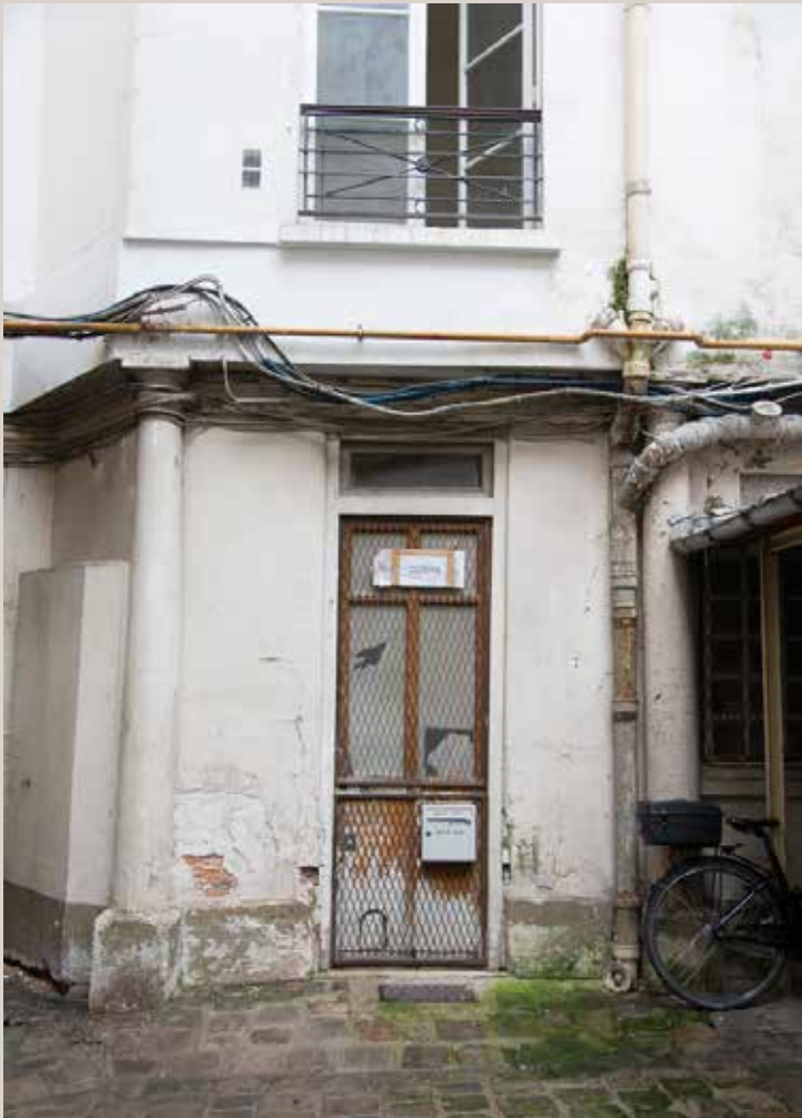
Vue actuelle du rez-de-chaussée de l'aile sur cour montrant, entre les colonnes, l'entrée d'un ancien atelier. Cette aile serait isolée par l'extérieur.
