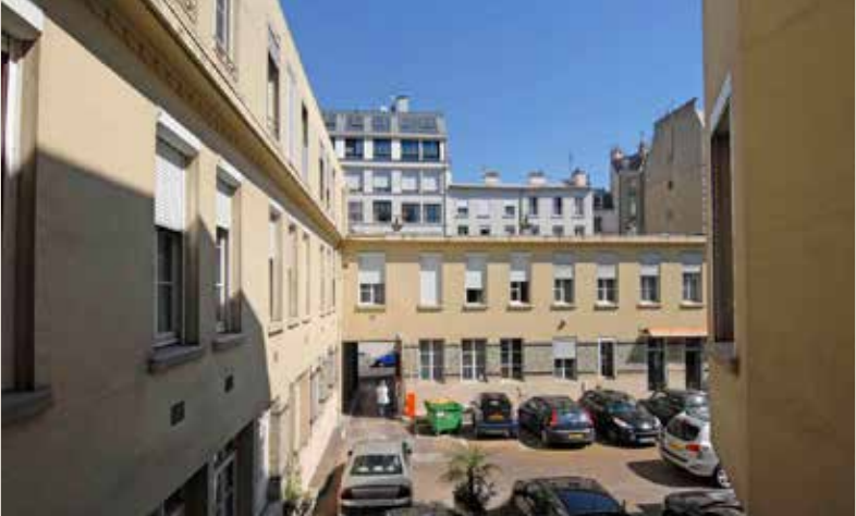
Vue actuelle depuis le fond de la parcelle vers le porche d'entrée et la rue Marcadet. L'aile sud a été surélevée à une date indéterminée.
