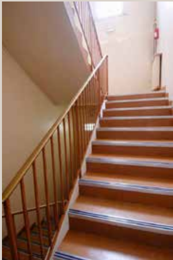
Vue actuelle de l'un des escaliers.
