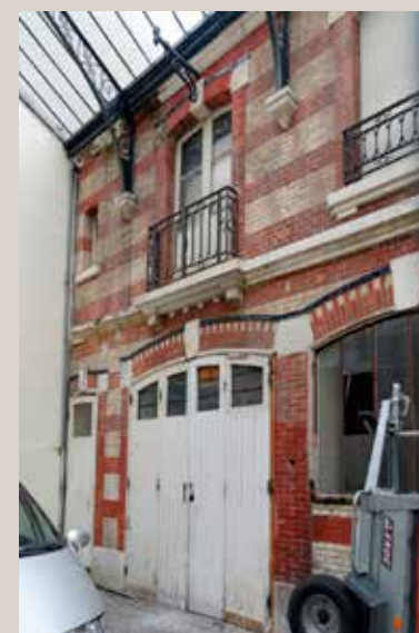
Vue actuelle de la façade en retour sur cour. Les percements seraient déplacés pour l'aménagement d'un logement.
