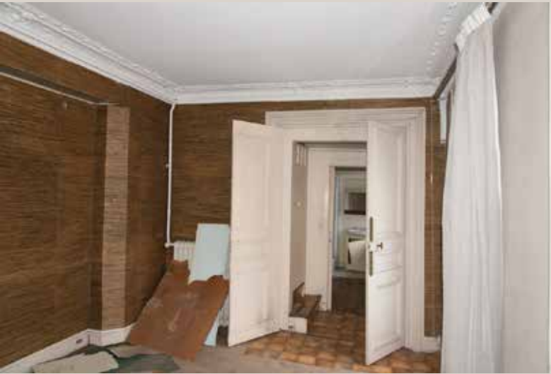
Vue actuelle d’un appartement sur rue.
