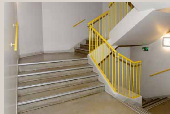
Vue actuelle de l'escalier qui a remplacé le grand escalier d'origine.
