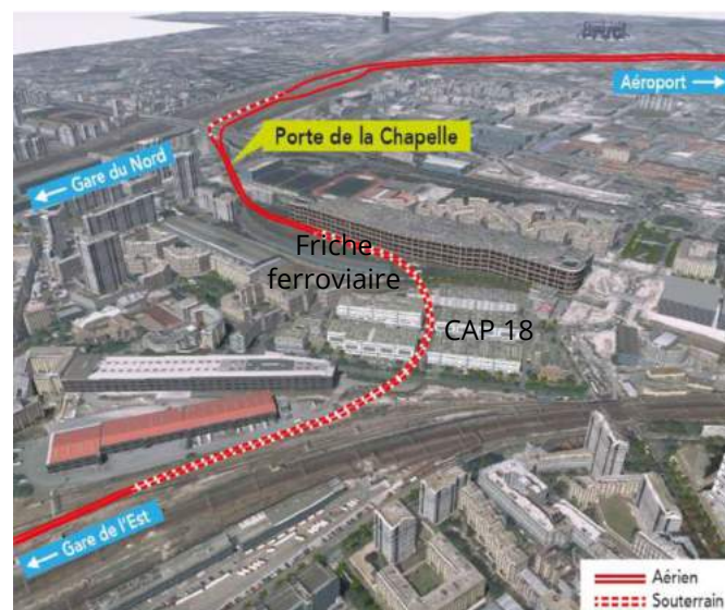
Passage du CDG Express dans le secteur Chapelle Charbon (source CDG Express, 2016)
