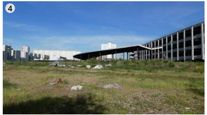
4 Friche ferroviaire (source TRANS-FAIRE, 2017)
