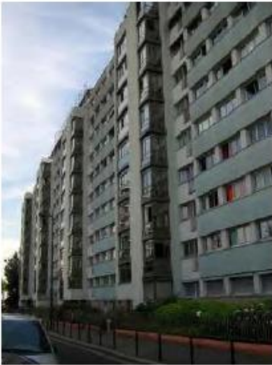
DP 7.1 - Photo de l'existant
