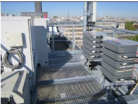
PHOTO APRES TRAVAUX (AJOUT DE 3 MODULES)
