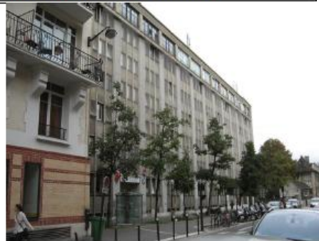
PHOTO DEPUIS LA RUE AVANT TRAVAUX
