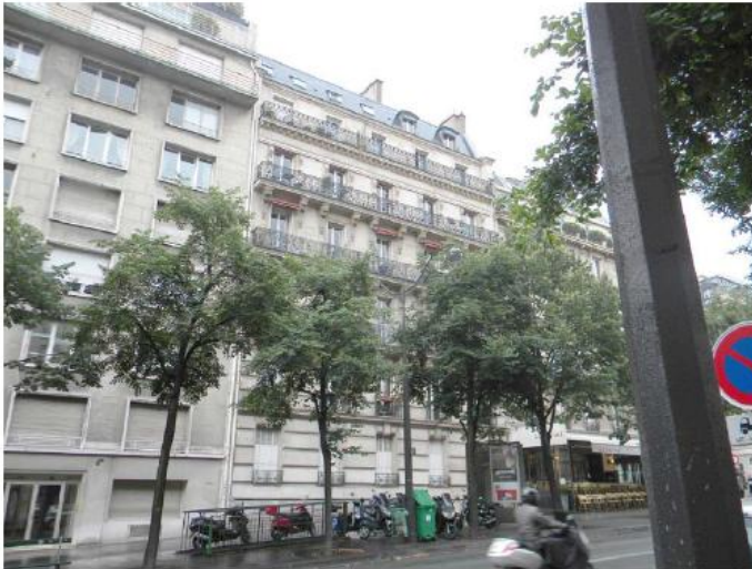
DP 7.1 - Photo de l'existant
