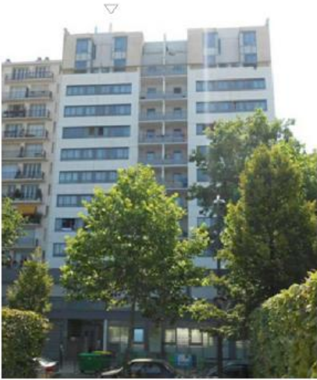
DP 7.1 - Photo de l'existant
