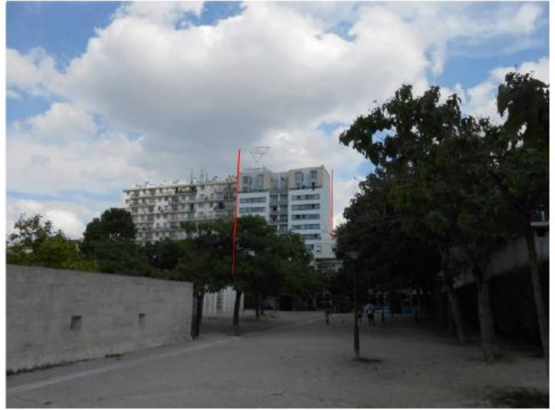
DP 8 - Photo de l'existant, vue lointaine
