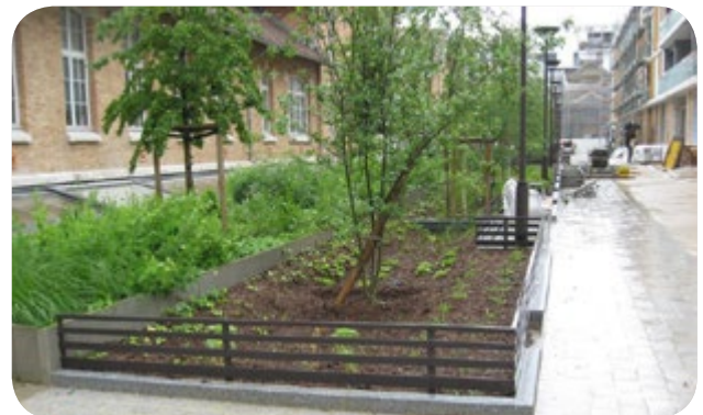
Les espaces verts et une noue contribuent à l'infiltration des eaux de ruissellement dans l'éco-quartier Boucicaut (15 e )
