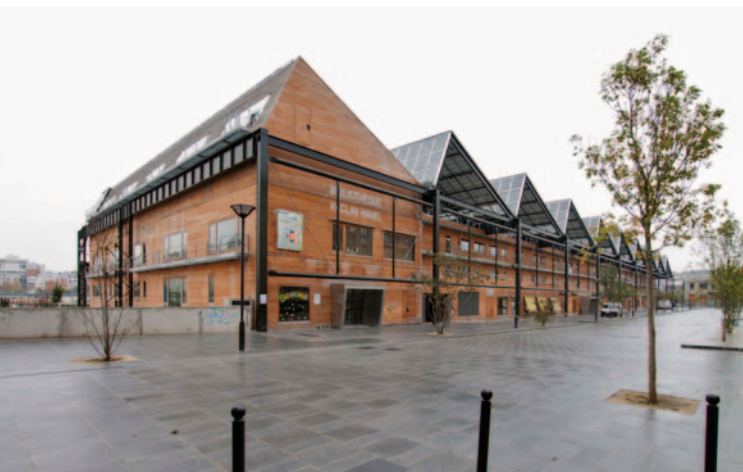
La halle Pajol (18 e ), un multi-équipement à énergie positive © Mairie de Paris, DPA
