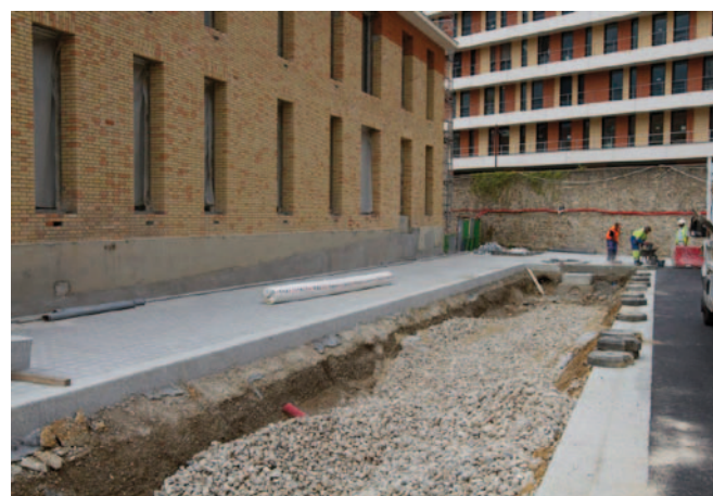
Nouveaux chantiers dans l'hôpital Broussais (14 e ) © Mairie de Paris, DVD
