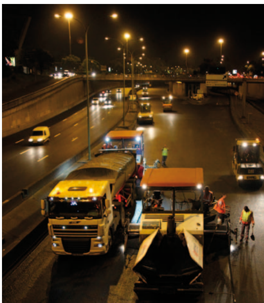
Pose d'enrobés phoniques – © Mairie de Paris
