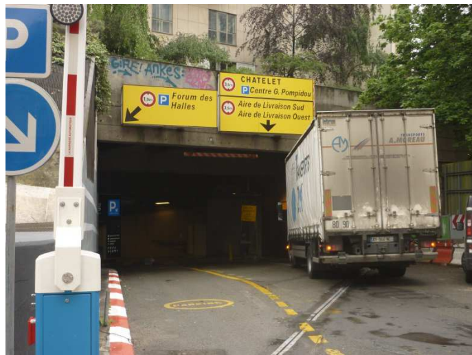
Photo 1 : Voie d'accès depuis la rue Turbigo - Source : DVD
