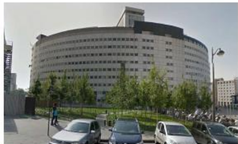
PHOTO DEPUIS LA RUE AVANT TRAVAUX
