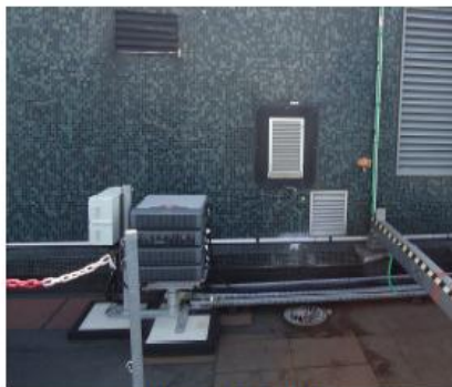
PHOTO AVANT TRAVAUX
