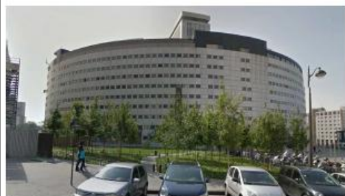
PHOTO DEPUIS LA RUE APRES TRAVAUX (SANS IMPACT VISUEL)
