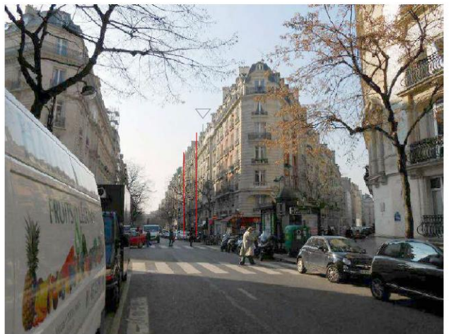
DP 8 - Photo du projet, vue lointaine
