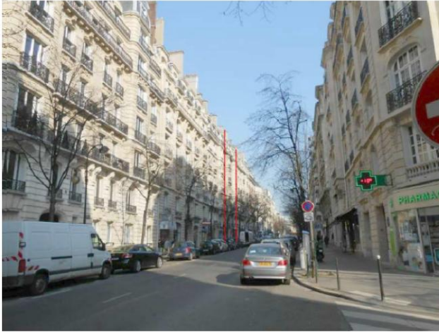
DP 7.1 - Photo de l'existant
