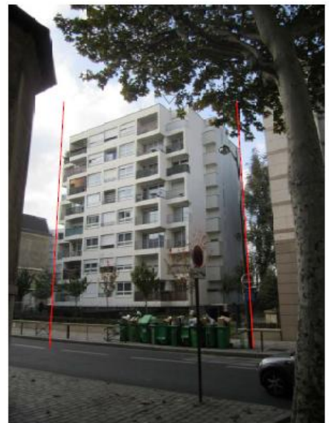
DP 8 - Photo du projet, vue lointaine
