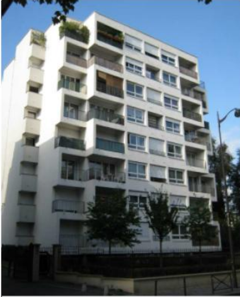
DP 7.1 - Photo de l'existant
