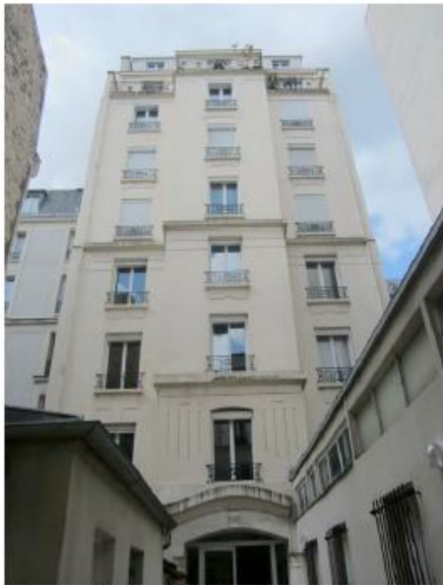
DP. 7.1. Photo de l'existant
