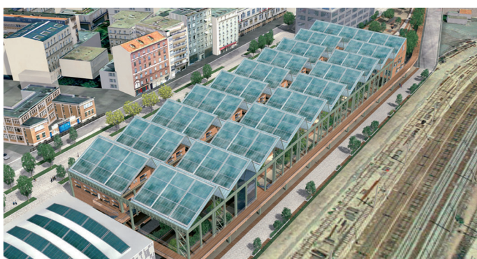
2012 - Panneaux solaires photovoltaïques Halle Pajol - 18 ème
