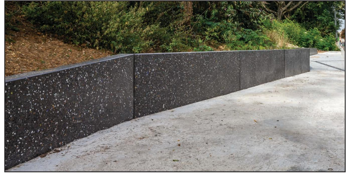
Le mur de soutènement est un mur en L en béton armé préfabriqué posé sur un béton de propreté. La hauteur totale du mur varie entre 0,80 m et 2,00 m. La partie visible du mur, par contre, ne dépasse pas 1.35 m. Afin de minimiser les impacts sur les arbres existants, la semelle du mur est disposée au-dessous du trottoir. Cette position de la semelle limite dans le futur la possibilité de positionner des réseaux sous le trottoir Sud.
