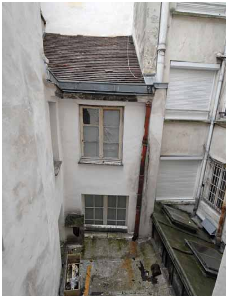
Ci-dessus : vue, depuis le corps de bâtiment sur rue, sur le mur d'héberge qui ferme le terrain et vue actuelle du bâtiment à simple épaisseur à l'arrière du terrain, qui serait conservé.
