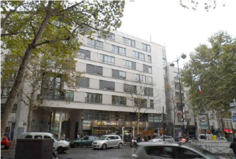
DP 7.1 - Photo de l'existant
