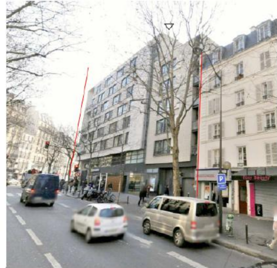
DP 8 - Photo de l'existant, vue lointaine
