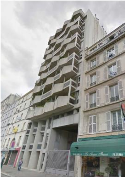
DP 7.1 - Photo de l'existant
