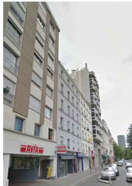
DP 8 - Photo du projet, vue lointaine
