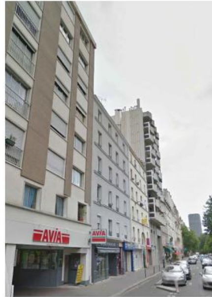
DP 8 - Photo de l'existant, vue lointaine
