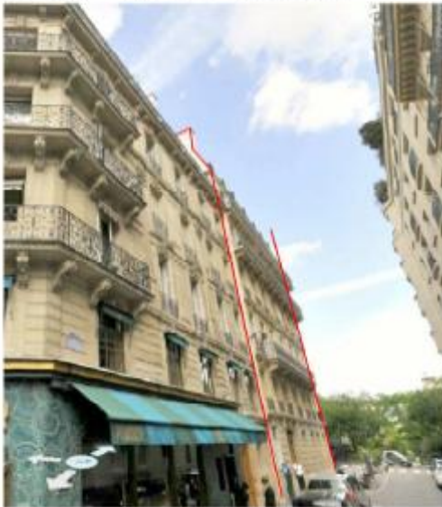
DP 6.1 - Photo du projet (l'antenne est invisible depuis ce point de vue)
