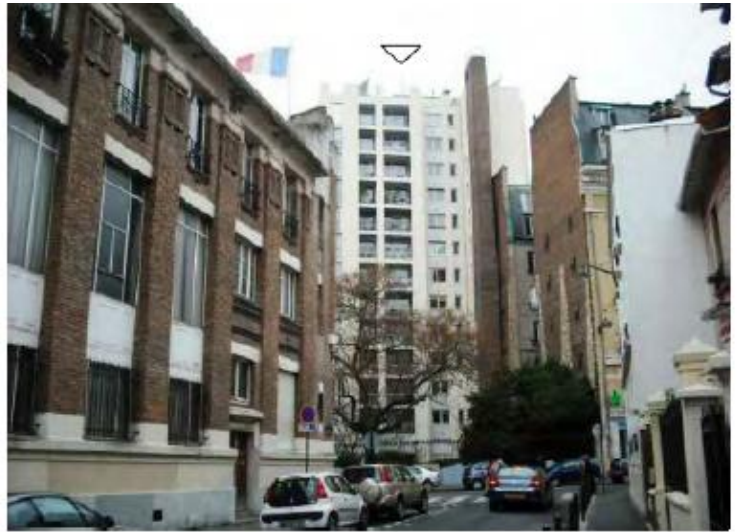
DP 7.1 - Photo de l'existant
