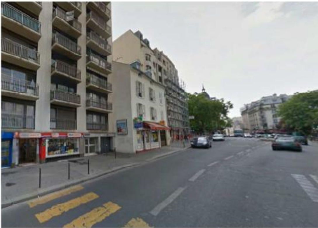
DP 7.1 Photo de l'existant
