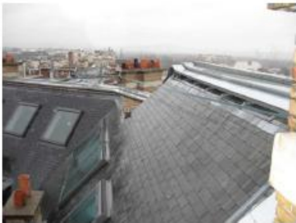
PHOTOS DEPUIS LE MAT DE L'ANTENNE AZ : 270°
