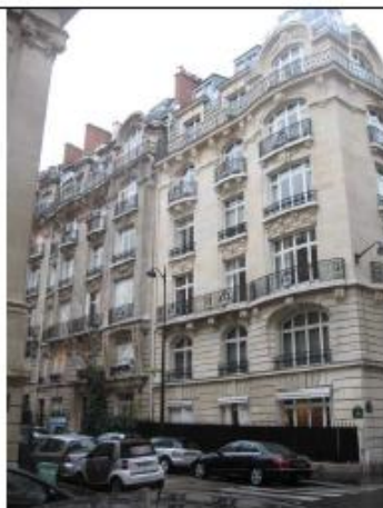
PHOTO DEPUIS LA RUE APRES TRAVAUX (SANS IMPACT VISUEL)
