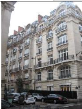
PHOTO DEPUIS LA RUE AVANT TRAVAUX
