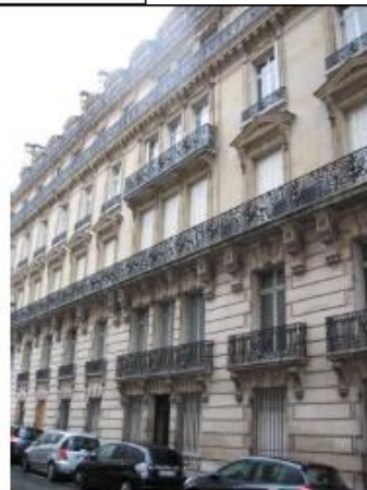
PHOTO DEPUIS LA RUE AVANT TRAVAUX
