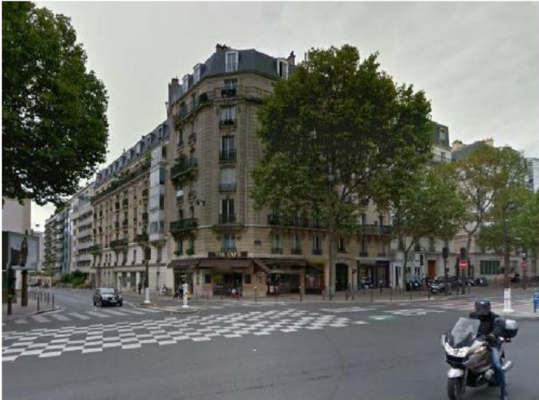
DP 7 Photo de l'existant
